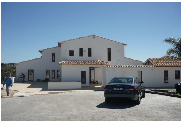
Vivienda unifamiliar en Gandía, Valencia. 2012.
