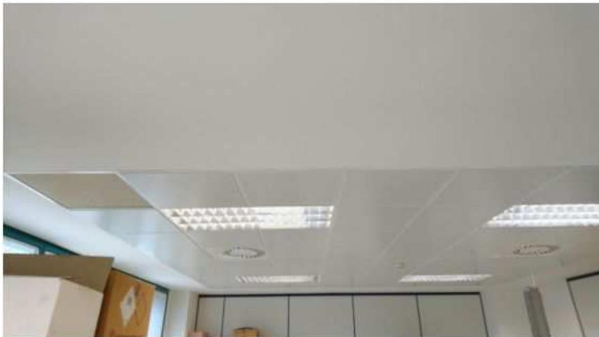
Falso techo acústico, colgado, con estructura independiente, de módulos metálicos a arranques en pared de placa de yeso.
